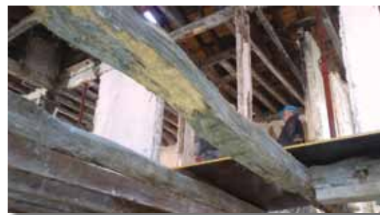
Reprise totale des planchers dans le cadre de la réhabilitation lourde de la résidence rue des Moines PARIS 17 e
