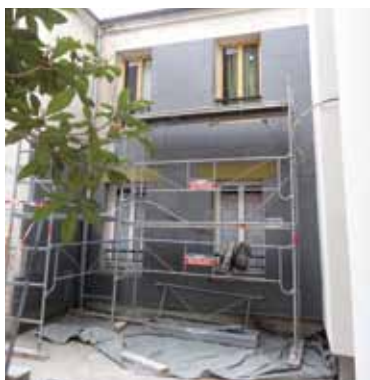
Isolation de la façade sur cours de la Résidence Lebneitz PARIS (75).
