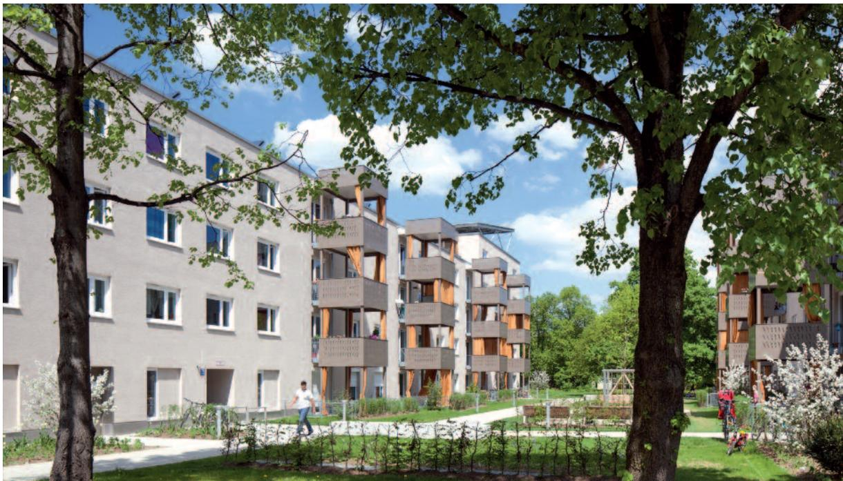
Im Zuge des Projektes „CO<sub>2</sub>-neutrale Energieversorgung“ in der Wohnanlage „Lilienhof“ wurde in Zusammenarbeit mit dem Fraunhoferinstitut für Bauphysik ein Forschungsprojekt aufgelegt, dessen Ziel es ist, eine beispielhafte energetische Sanierung durchzuführen mit einem Primärenergiebedarf für Beheizung und Trinkwassererwärmung der mindestens 50 % unter den zulässigen Werten eines Neubaus liegt.
