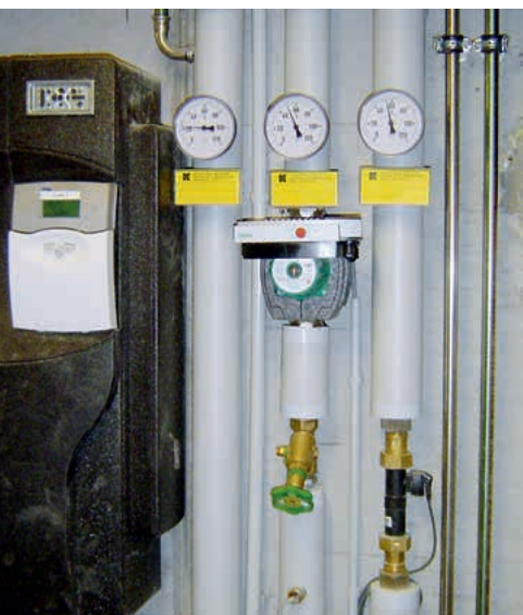
Zentrale Trinkwassererwärmung im Durchflusssystem
