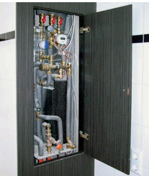
Schachtverkleidung mit Revisionsöffnung
