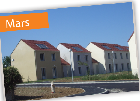
01/09/12 : Réception de 40 logements, Rue François Couperin - Château Landon (77). THPE 2005 - Certification Qualitel et H&E.
