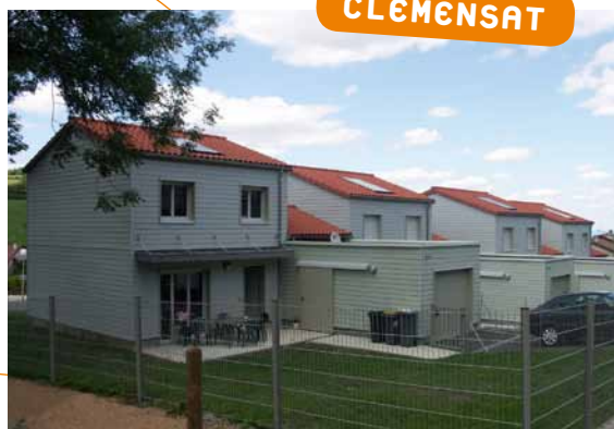
Résidence Les Aubépines : 4 pavillons labellisés BBC
