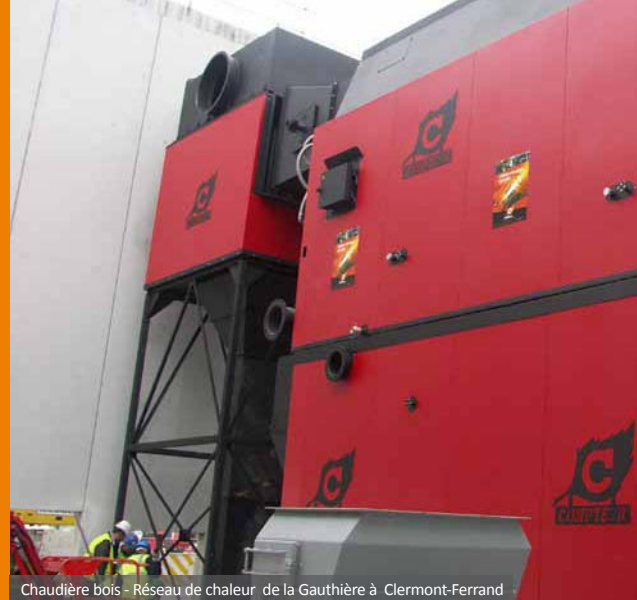
Chaudière bois - Réseau de chaleur de la Gauthière à Clermont-Ferrand
