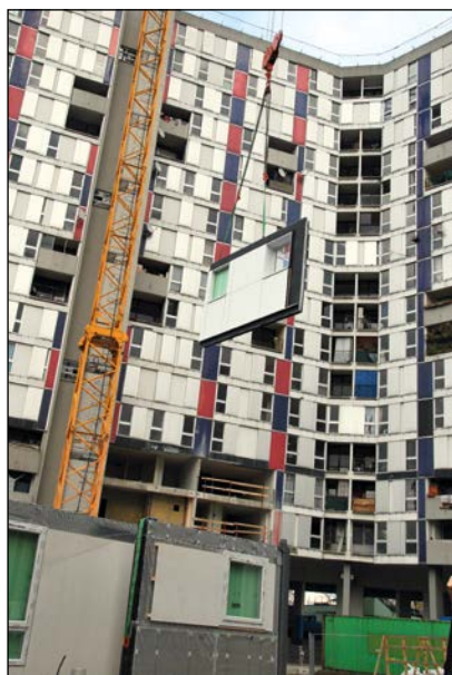
Changement des modules de la façade du 40, galerie Arlequin (Grenoble).
