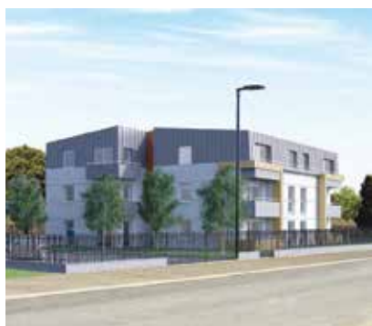
La résidence adaptée de DAINVILLE : 12 logements collectifs et une salle de conviabilité prévus pour octobre 2017
